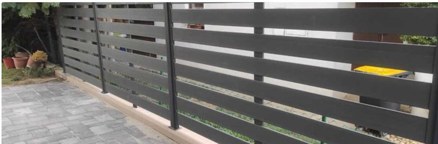
Vodoravna izvedba, grafit — postavljena ograja
